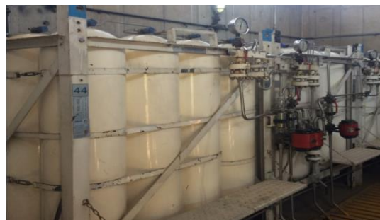
شکل ۵- اتصال مخازن ذخیره با لوله‌های فشار قوی
